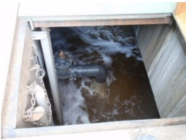
処理水槽内部
